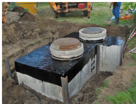
Опорные кольца и чугунные люки на КПО и смежном колодце
