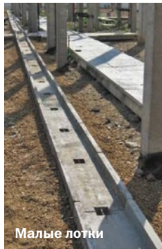
Переход малых лотков через существующую канализацию
